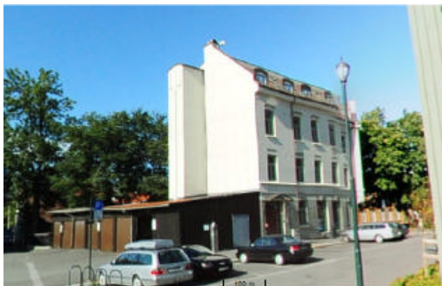
Fig. 2: Foto fra eksisterende situasjon i Schultz gate
