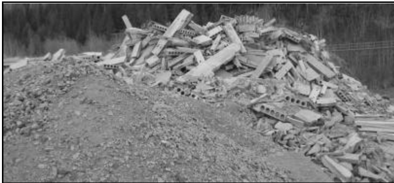
Knusing og gjenvinning av betongelementer.
